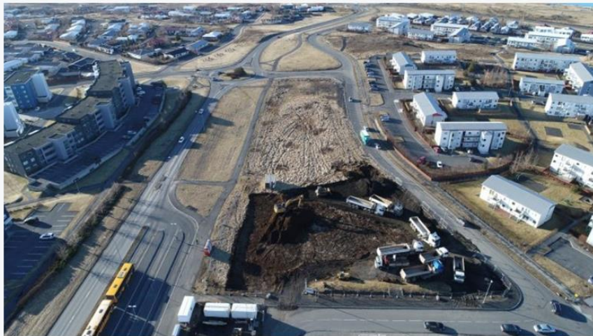
Framkvæmdir komnar af stað við Móaveg
